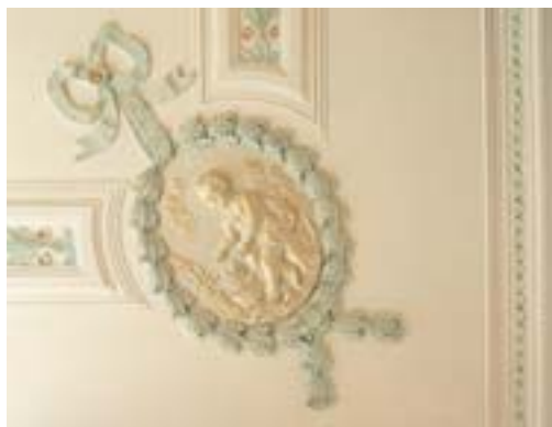
Stuckdecke (um 1790) im ehemaligen Saal des 1. Obergeschosses nach der Restaurierung. Links: Zentrales Stuckmedaillon, Zustand August 2004. Rechts: Eckkartusche mit Putto, Zustand August 2004. KDP Fotoarchiv.
