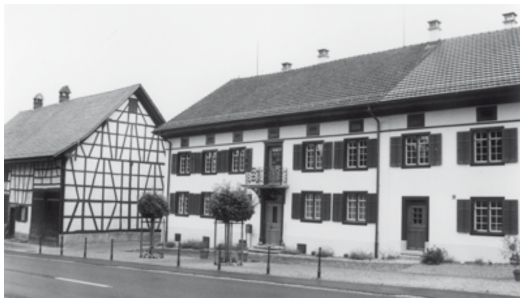
Teilansicht der Nordfassade mit Hauseingang. Zustand nach der Gesamtrenovation, August 2006. KDP Fotoarchiv.
