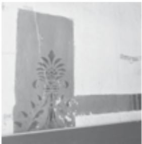
Dekorationsmalerei im Erdgeschoss-Korridor (um 1900). Zustand während der Freilegung, Januar 2004. KDP Fotoarchiv.
