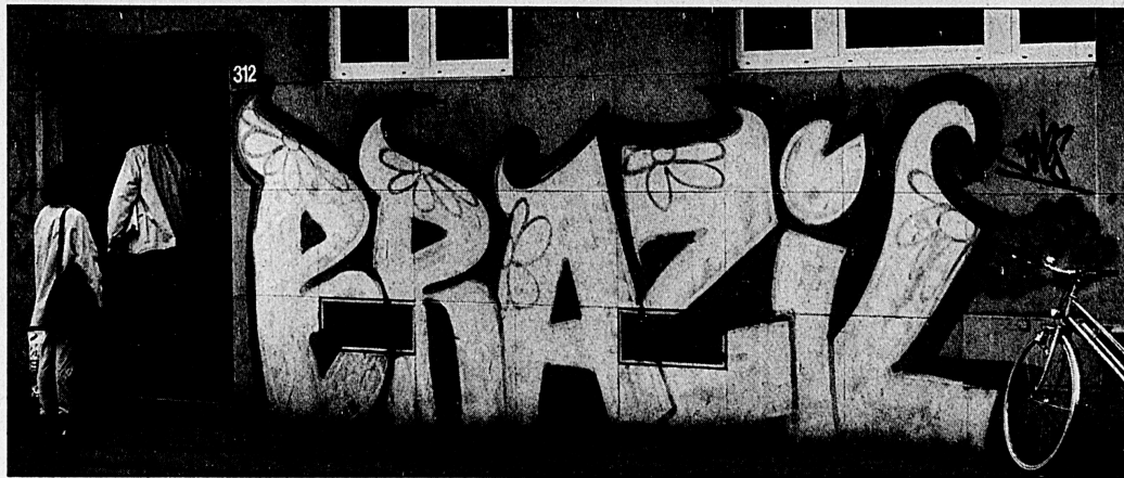
Schmierereien an Hausfassaden sind vor allem in der Zürcher Innenstadt ein ständiges Übel, dem nur schwer beizukommen ist. (Bild hf.)
