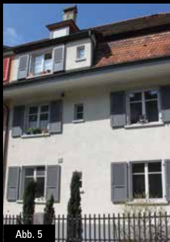
Abb. 5: Im Rahmen des Projekts energetisch saniertes Stadthaus in Bern: Der U_g -Wert wurde von 2,8 auf 0,75 \text{ W}/(\text{m}^2 \cdot \text{K}) verbessert, das Schalldämmmaß um 13 dB erhöht und die Luftdurchlässigkeit um 93% reduziert.
