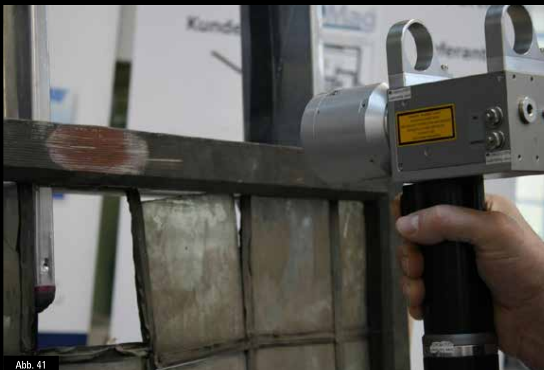
Abb. 41: Laserbasiertes Abreinigen von altem Lack auf einem Holzfenster
