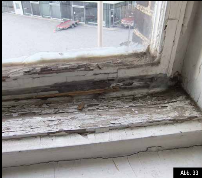
Abb. 33: Schäden am Lack, Schädlingsbefall und eine marodierende Holz- und Bausubstanz infolge anhaltender Durchfeuchtung
