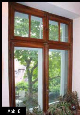
Abb. 6: Im Rahmen des Projekts energetisch saniertes Stadthaus in Basel, Eichenfenster mit Vorfenster: Bei der Sanierung wurde das Vorfenster ausgebaut und das Permanentfenster durch Einsatz einer Sonderisolierverglasung und einer Dichtungsebene energetisch ertüchtigt. Der U -Wert der Verglasung U_g verbesserte sich in Summe der beiden Fenster von 2,8 auf 0,9 \text{ W}/(\text{m}^2 \cdot \text{K}) . Da das Vorfenster nicht wieder eingebaut wurde, verschlechterte sich das Schalldämmmaß leicht von 28,9 auf 27,8 dB.
