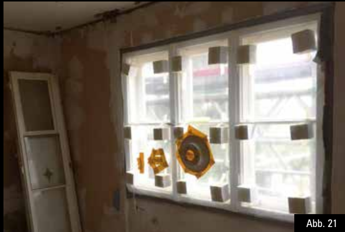
Abb. 21: Fenster mit variablen Abstandshaltern, verklebter Folie und Lochblende
