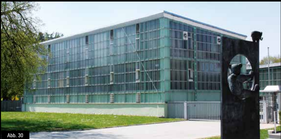
Abb. 30: Giengen an der Brenz, Produktions- halle der Firma Steiff, 1903: zweischalige Glasfassaden
