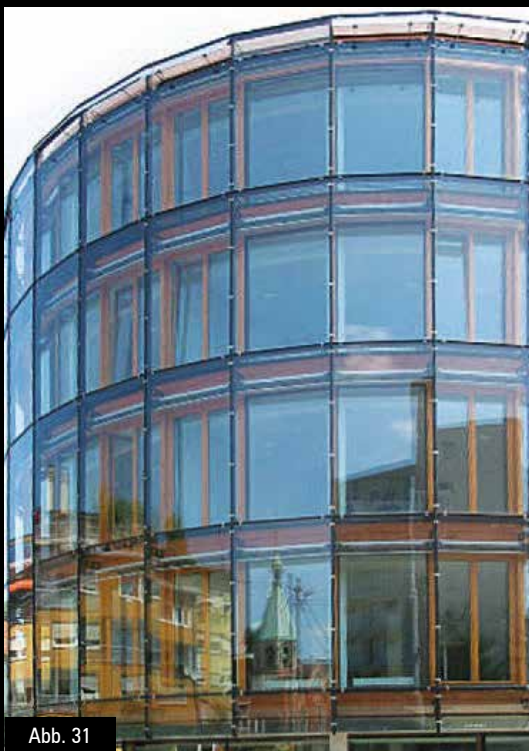
Abb. 31: Stuttgart, Hegelstraße 33: Die Kastenschichtfassade (Glasdoppelfassade) soll neben mehr Wärme auch eine schallschutztechni- sche Verbesserung bewirken.
