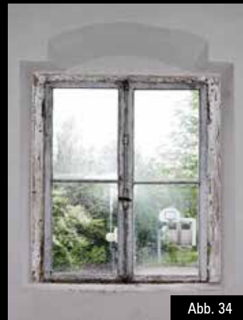
Abb. 34: Alte Schöfflerei, Kloster Benediktbeuern, OG, Nordseite, Fenster 1.26: Außen- und Innenansicht des Bestandsfensters im Vorzustand, Stockaußenmaß 1,14 m × 1,40 m (1,60 m 2 )
