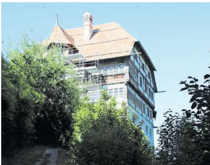
Die Gesamtrenovierung von Schloss Zuckenriet wird noch Jahre dauern.
