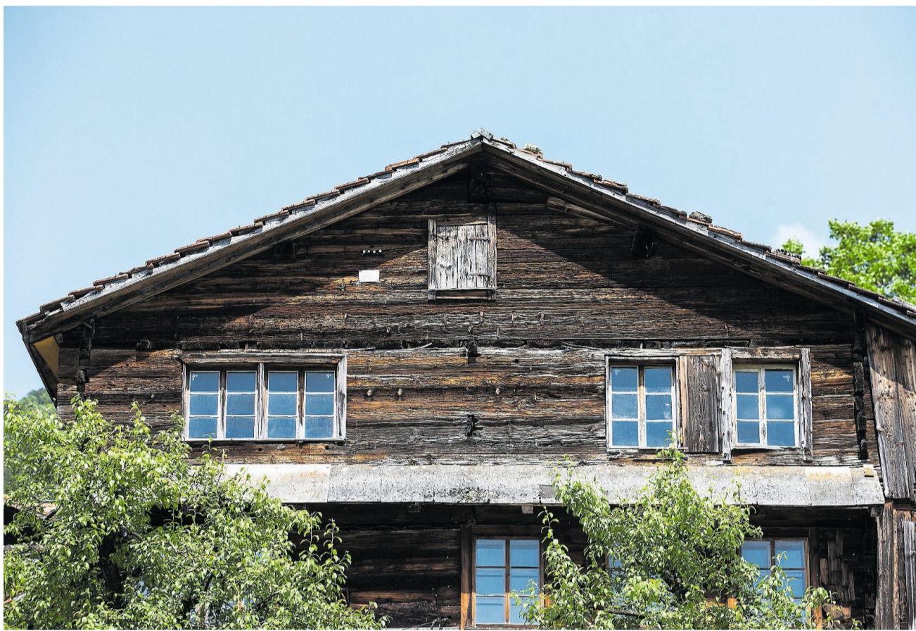
In Steinen im Kanton Schwyz wäre dieses Holzhaus aus dem Jahre 1305 beinahe abgerissen worden.
