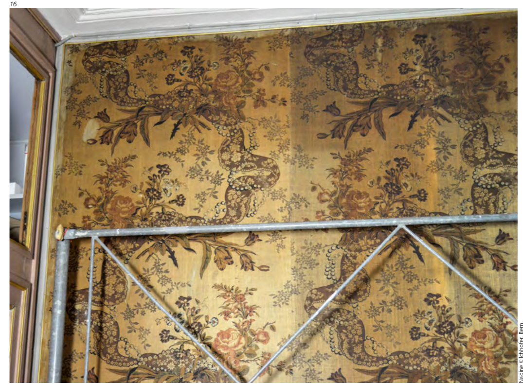
Abb. 16 Der linke Teil der Wandbespannung ist mit dem Latexschwamm gereinigt worden, rechts zum Vergleich der noch verschwärzte Bereich.
