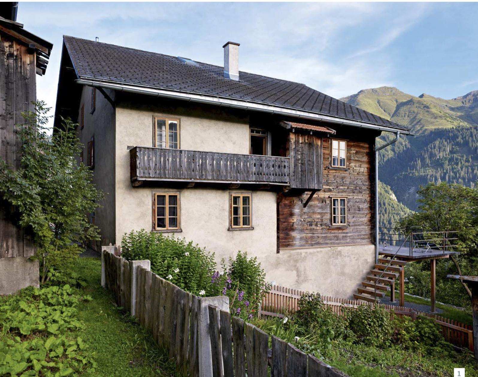
**1** Das Bauernhaus Casa Maus wurde 1917 in Bruchsteinmauerwerk und Strickbauweise errichtet.
