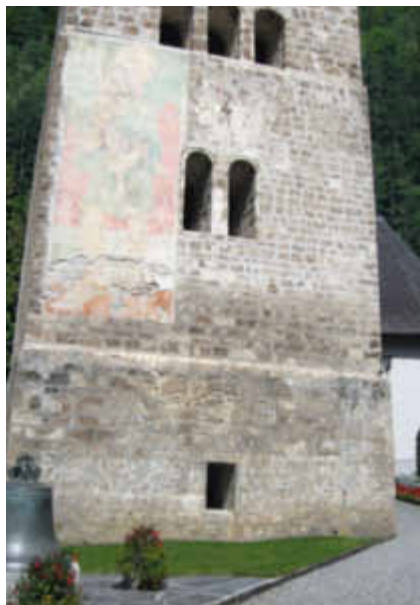
Ill. 4: Le clocher de l'église de Meiringen. Cette tour n'est pas équipée de chéneaux et l'eau du toit tombe directement sur le pied du mur ou y rejaillit depuis le sol. Ici, tout indique que «l'humidité» présente dans la maçonnerie et sur le crépi trouve son origine dans ce phénomène qui était probablement très courant sur de nombreux bâtiments par le passé.
