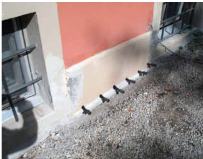
Injektionsverfahren beim Haus Kreuzmatt: Über Terrain werden in regelmässigen Abständen Bohrlöcher erstellt.
