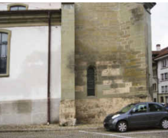
Abb. 2: Basilique Notre Dame, die älteste Kirche von Freiburg: Die Feuchtflecken bis in grosse Höhen können unter anderem dadurch erklärt werden, dass die Kirche am ehemaligen, heute aufgefüllten grossen, natürlichen Stadtgraben steht (das Auffüllmaterial war sicherlich nicht salzfrei), dass es entlang der Mauern lange Zeit einen Friedhof gab und dass hier jahrzehntlang diverse Märkte (auch Viehmärkte) stattfanden und die Zugtiere oftmals hier warteten.
