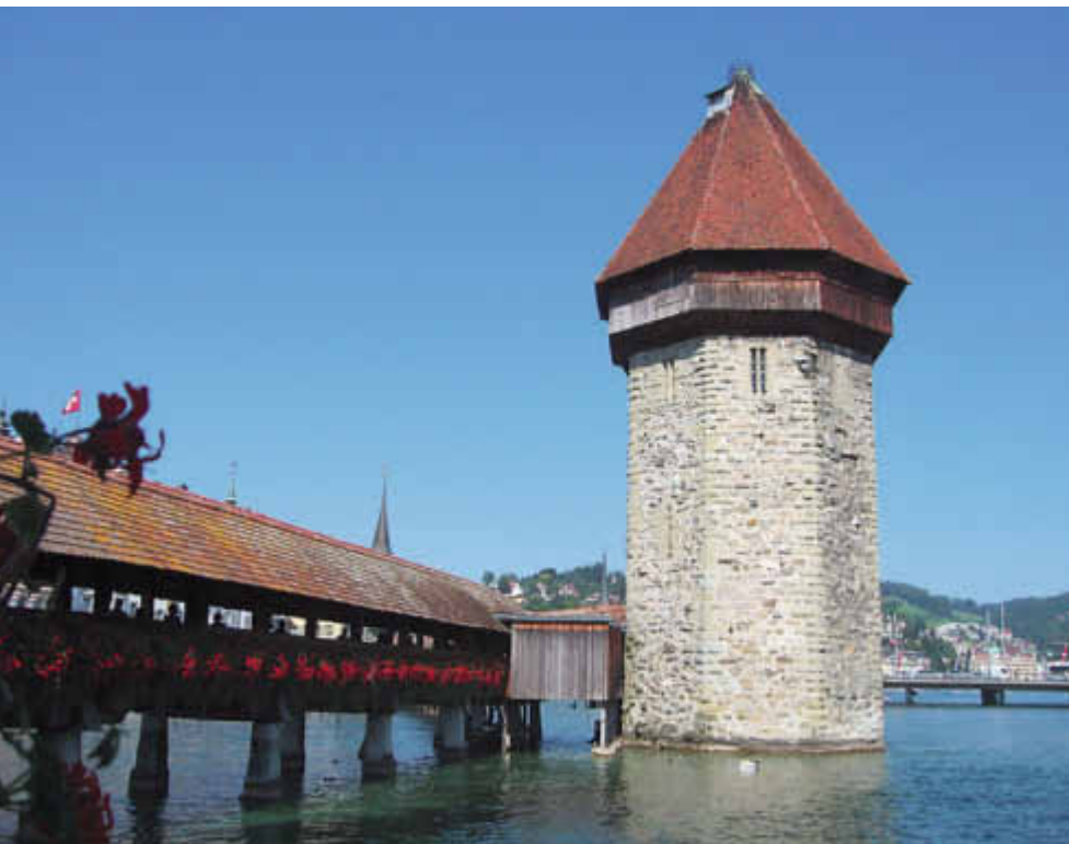
Abb.1: Der Wasserturm der Kapellbrücke Luzern am 20.8.2009; er steht seit 1330 im Wasser, und trotzdem ist oberhalb von etwa einem Meter keine aufsteigende Feuchtigkeit zu erkennen.
