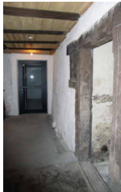
Le sol en ciment a été lacéré le long des murs pour créer une zone d'assèchement.
