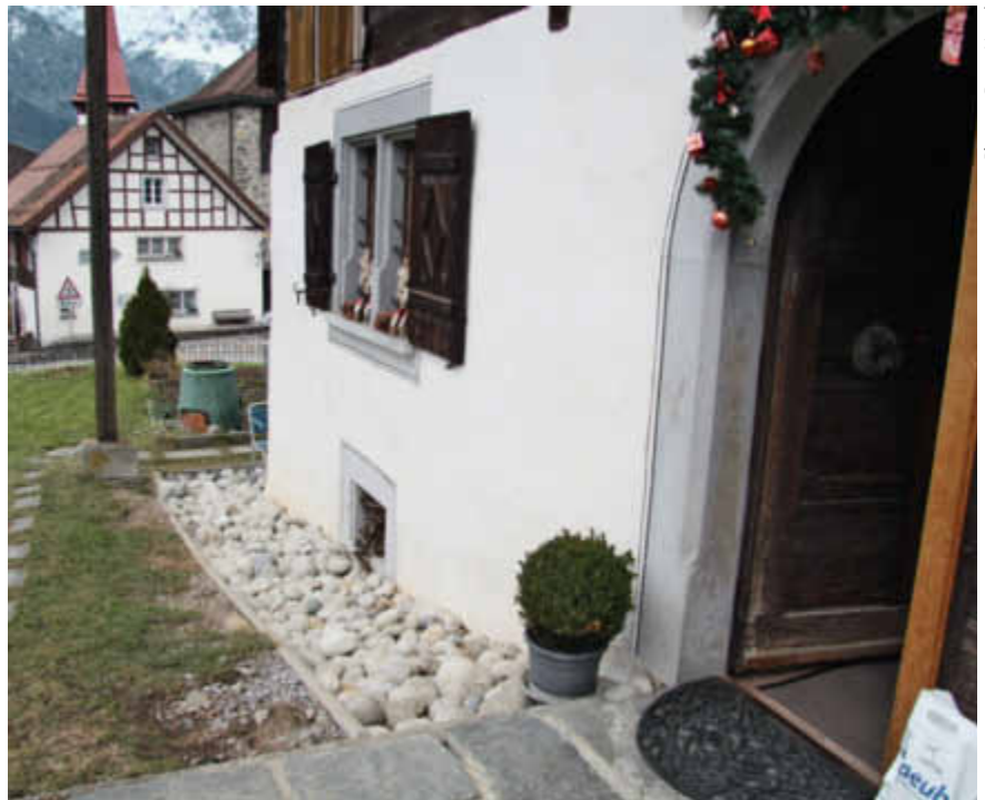
Un drainage a été construit le long du pied de mur à la maison «Planzer».
