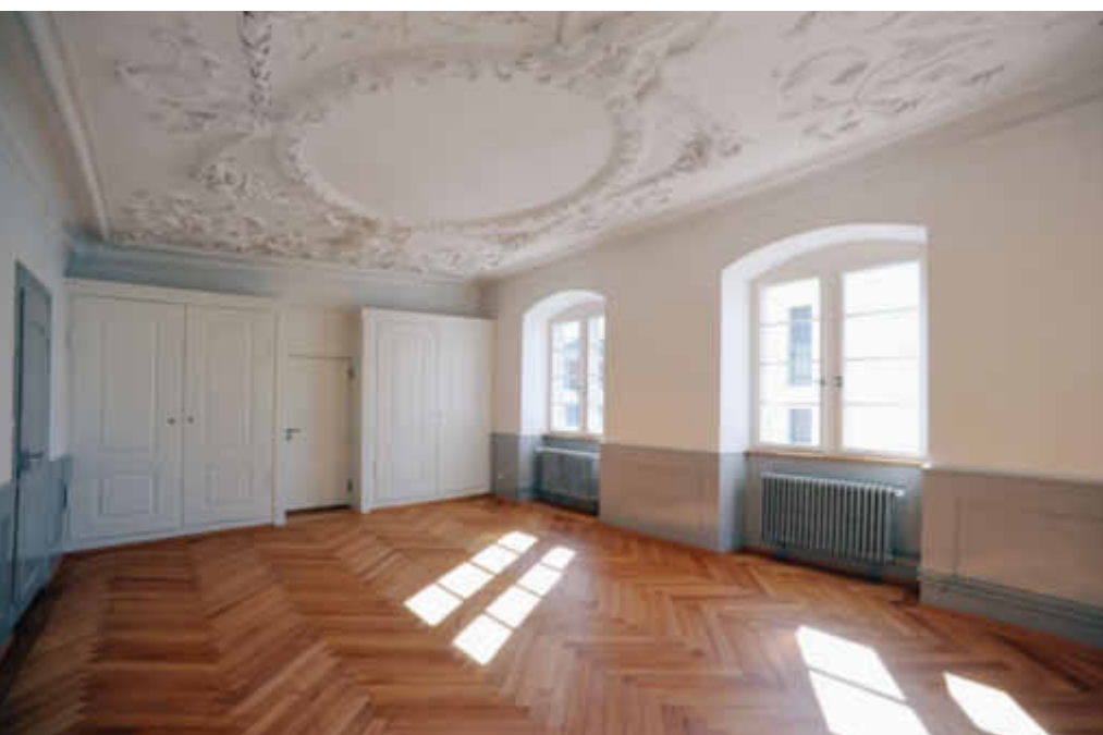
Die Stuckdecke im Saal des zweiten Obergeschosses nach der Restaurierung. Die übrige Ausstattung wurde farblich besser eingepasst.
