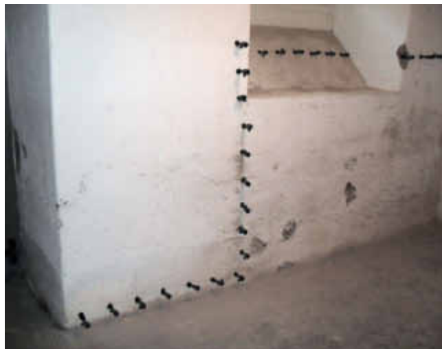
Über Bohrlöcher wird eine Microemulsion in das Mauerwerk eingebracht, die eine horizontale Sperrschicht bilden soll.
