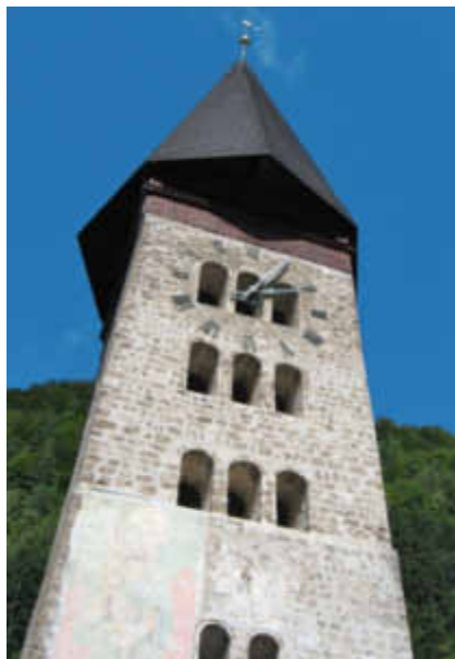
Ill. 4: Le clocher de l'église de Meiringen. Cette tour n'est pas équipée de chéneaux et l'eau du toit tombe directement sur le pied du mur ou y rejaillit depuis le sol. Ici, tout indique que «l'humidité» présente dans la maçonnerie et sur le crépi trouve son origine dans ce phénomène qui était probablement très courant sur de nombreux bâtiments par le passé.
