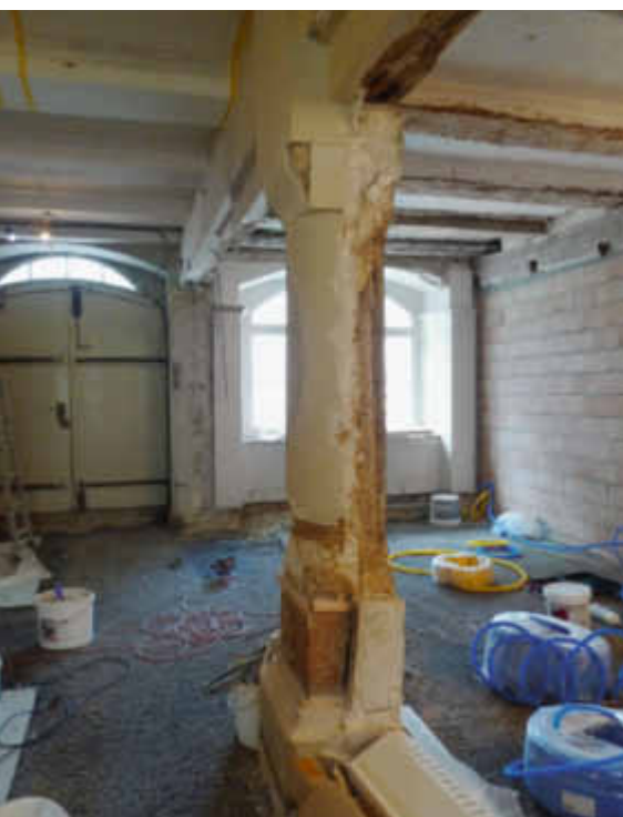
Die Eingangshalle während der Bauzeit und nach Entfernung der späteren Binnenwände
