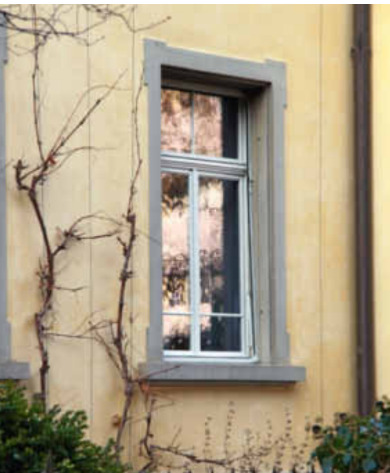
Für die äusseren Gläser wurde Goethe-Glas mit leicht gewellter Oberfläche verwendet, das dem ursprünglichen Erscheinungsbild ähnlich ist.
