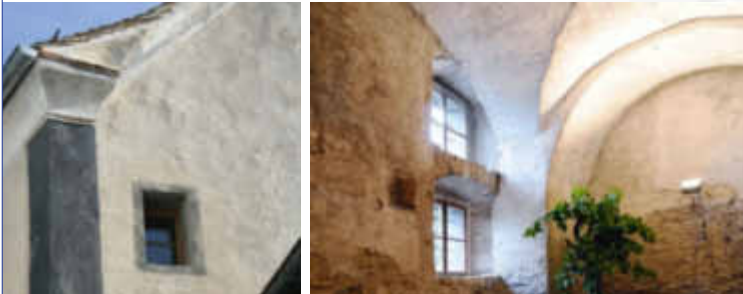
Putzfestigung und Putzrekonstruktion, Haus von Moos, Malans.
