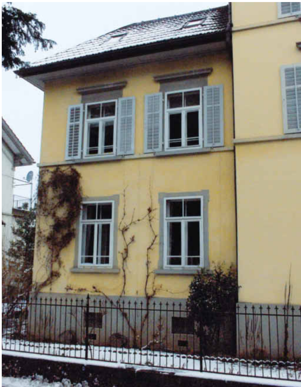
Avant les travaux: les fenêtres extérieures mises en place pendant les mois d'hiver
