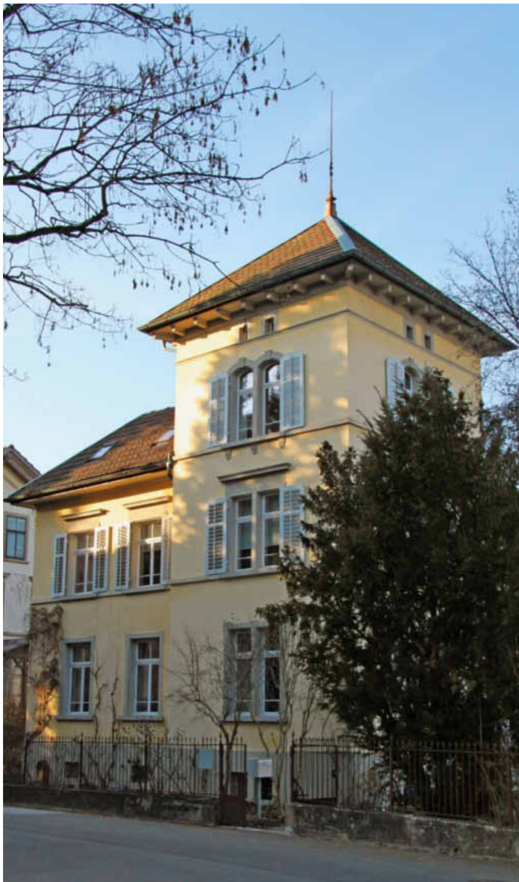
Der spätklassizistische Verputzbau stammt aus dem Jahr 1893. Die Fenster aus der Bauzeit wurden kürzlich saniert und energetisch aufgewertet.
