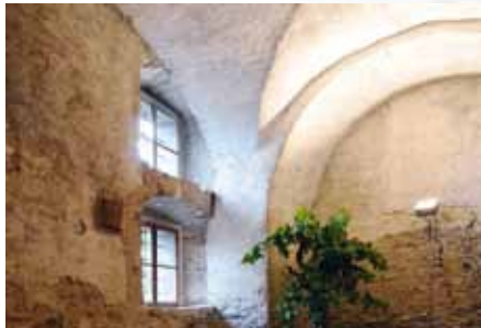
Putzfestigung und Putzrekonstruktion, Haus von Moos, Malans.
