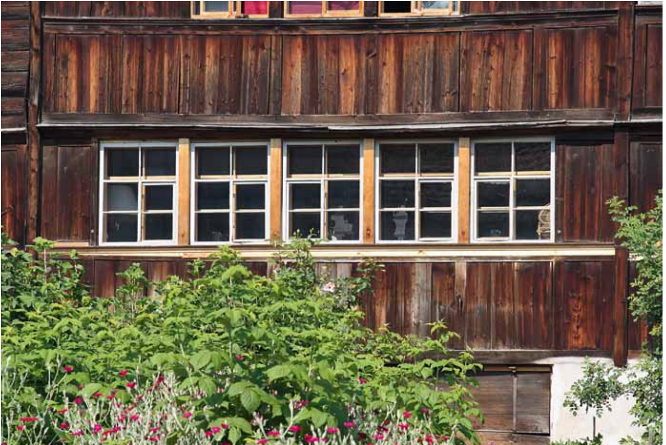
Unpassende Doppelverglasungsfenster wurden mit stilechten, einfach verglasten Schieberlifenstern ersetzt.
