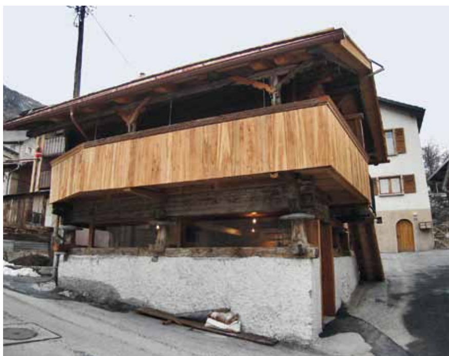
... et après la rénovation de 2008
