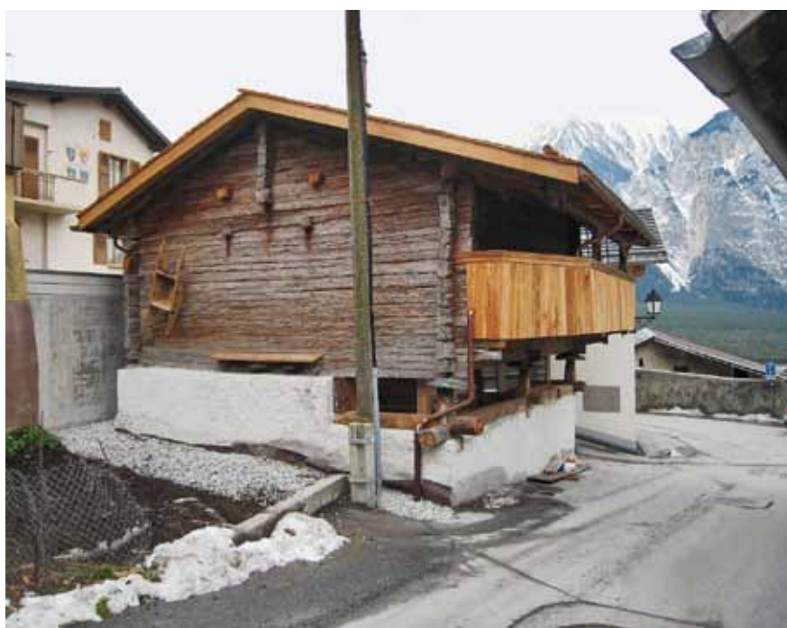
... und nach der Renovation im Jahr 2008.
