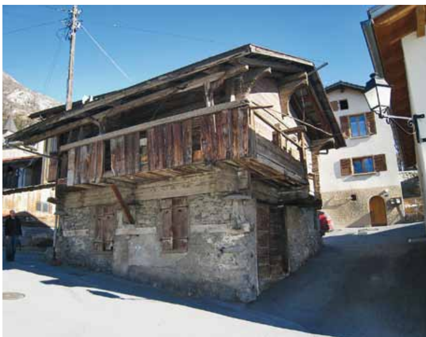
Les façades sud et ouest avec la galerie avant la rénovation ...
