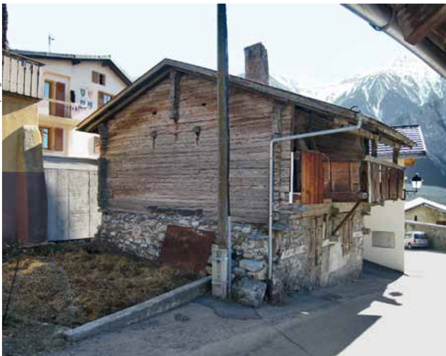
Nord- und Westfassade mit Laube vor...
