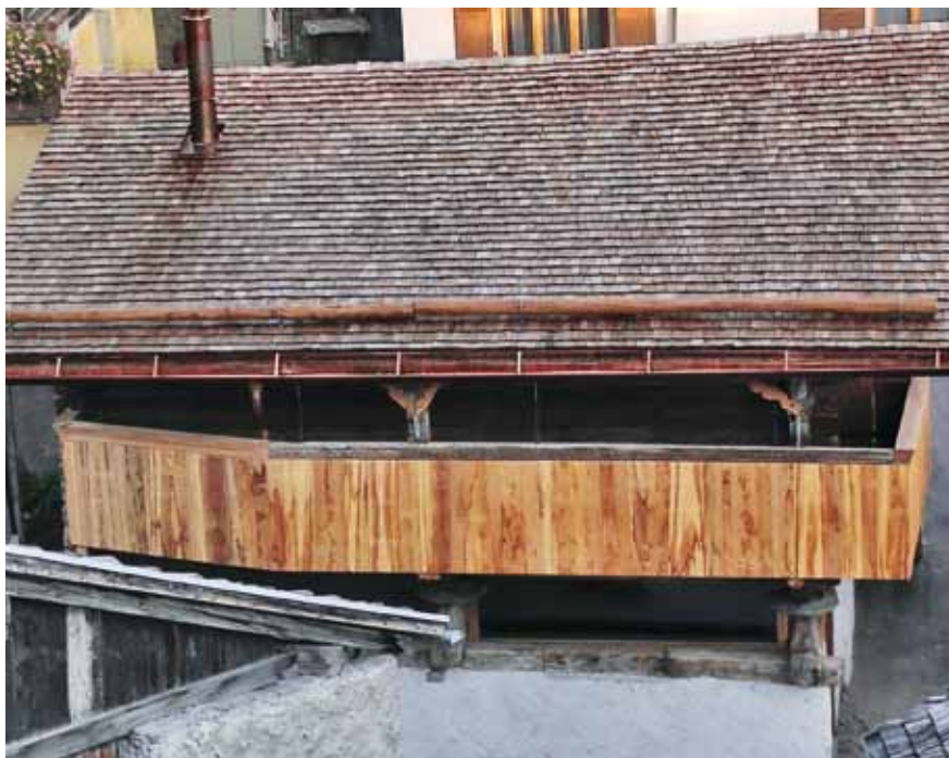
Nouvelle toiture de bardeaux en bois de mélèze
