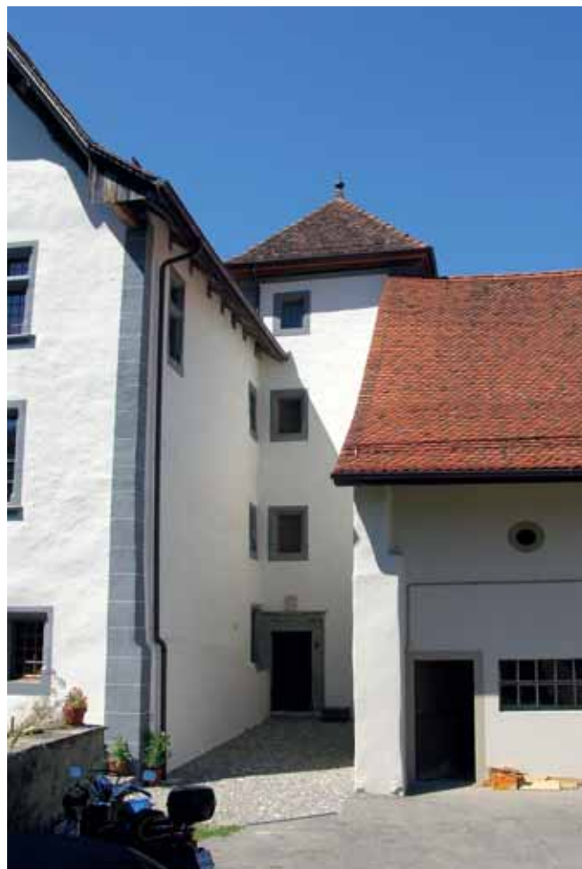
... und nach der Restaurierung
