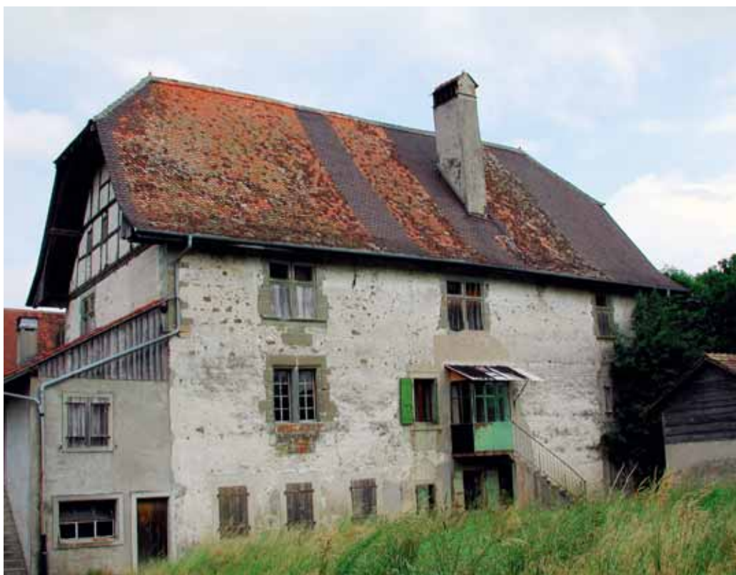
Façade ouest avant restauration
