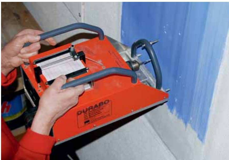
Examen de molasse et d'enduit par forage
