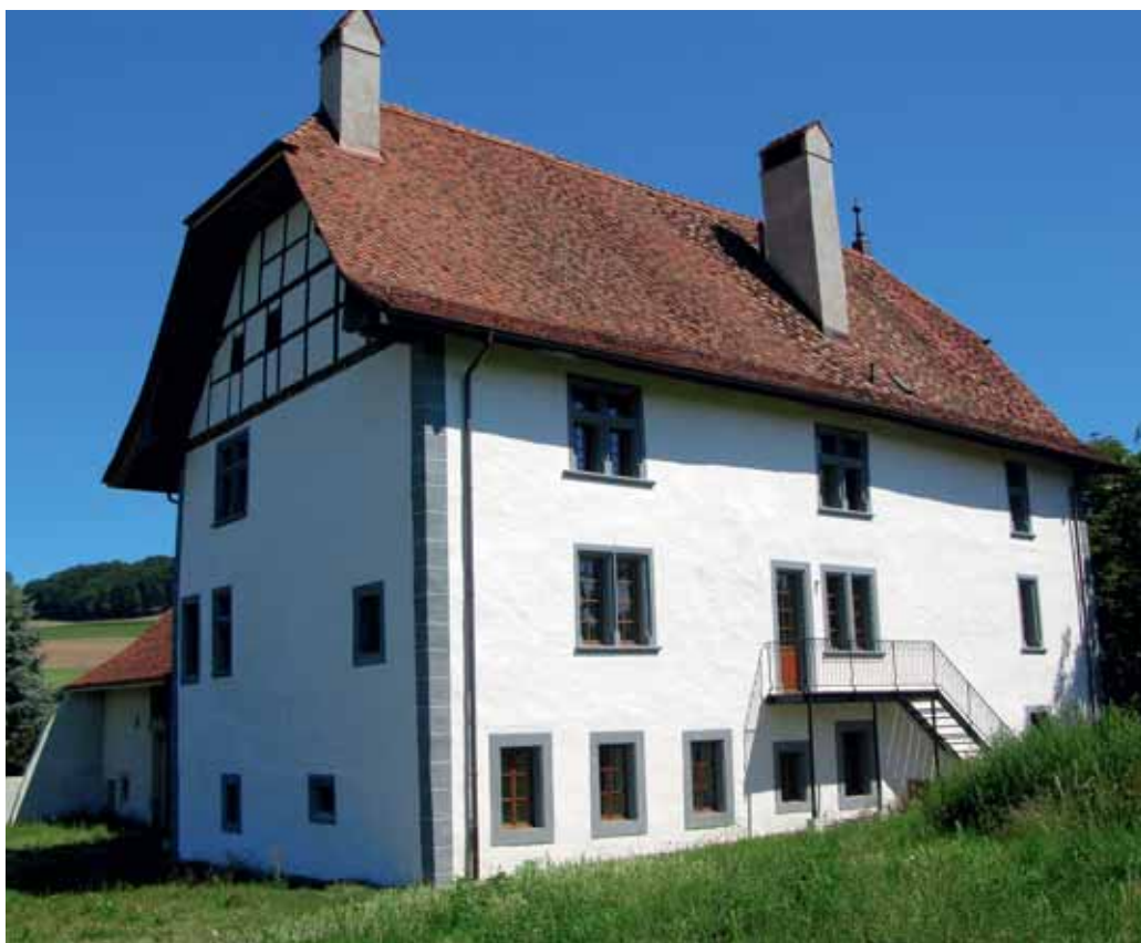
Façade ouest après restauration
