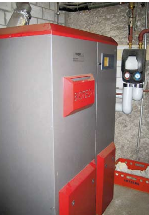
Chaudière 40 kW compacte
