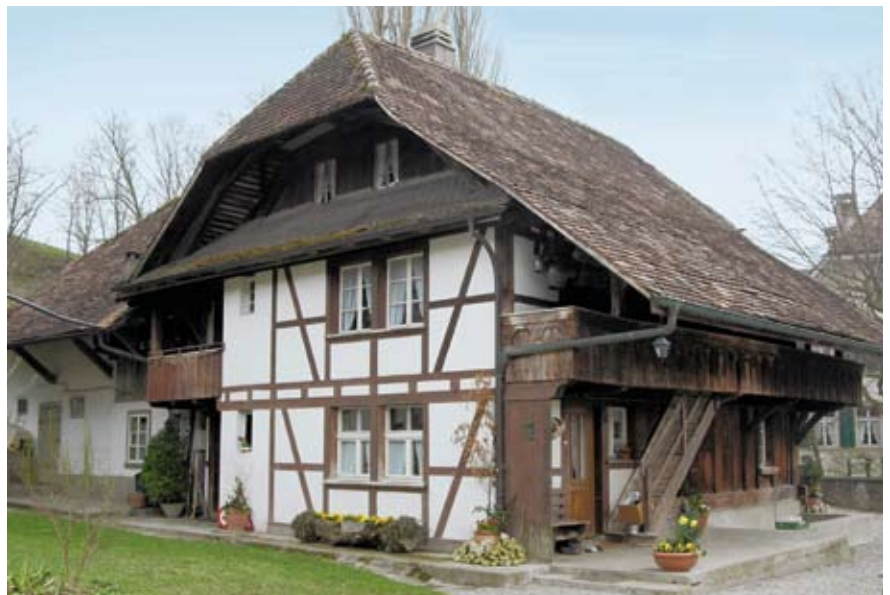
Suite à la rénovation, la ferme est à nouveau habitable.
