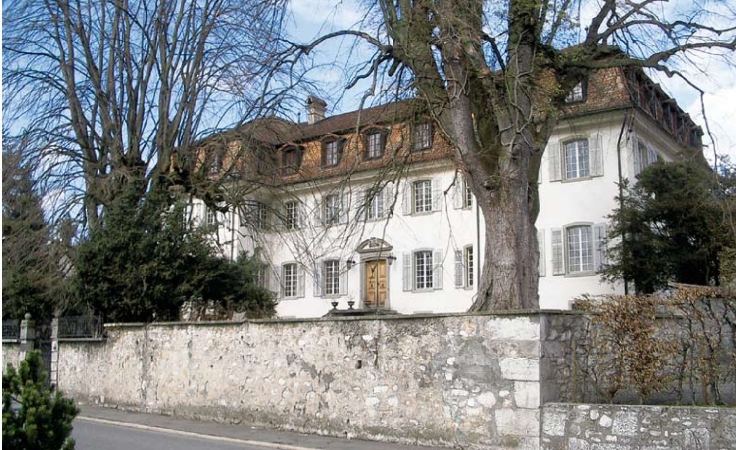
Schwyz, Palais von Weber («Friedberg»). Ansicht von Südosten.
