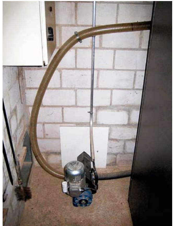
Schneckenantriebsmotor mit Saugschläuchen zum Tagesbehälter
