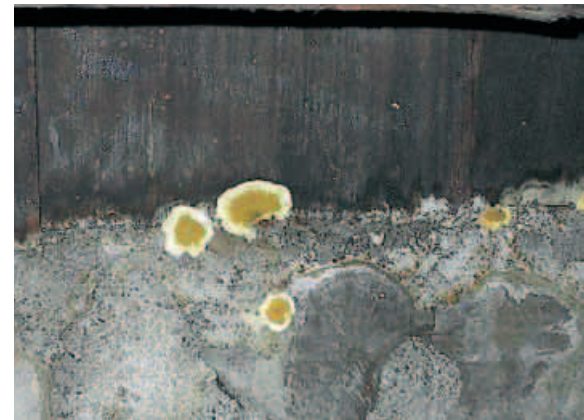
Kleiner ganz frischer Hausschwamm in einem Keller
