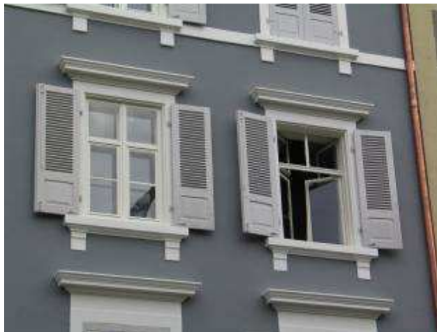
Ansicht der Fenstersituation von aussen mit den vorgehängten Winterfenster bzw. Vorfenster.
