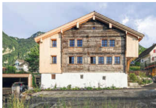
Der talseitige Hausteil und damit das Gesicht des Hauses ist vollständig erhalten und kommt seit dem Umbau wieder zum Vorschein. Bild: Regine Giesecke
